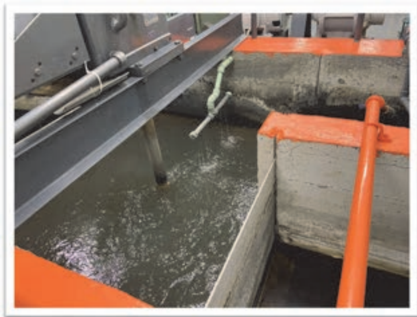
Photo 14 : Mélangeur au 2 e étage de l'usine de traitement (secteur 1125, avenue Saint-Édouard) – 17 décembre 2020
