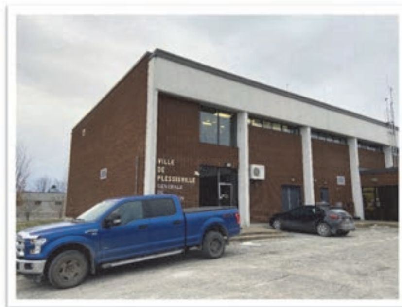
Photo 10 : Installation de l'usine de traitement (secteur 1125, avenue Saint-Édouard) – 17 décembre 2020
