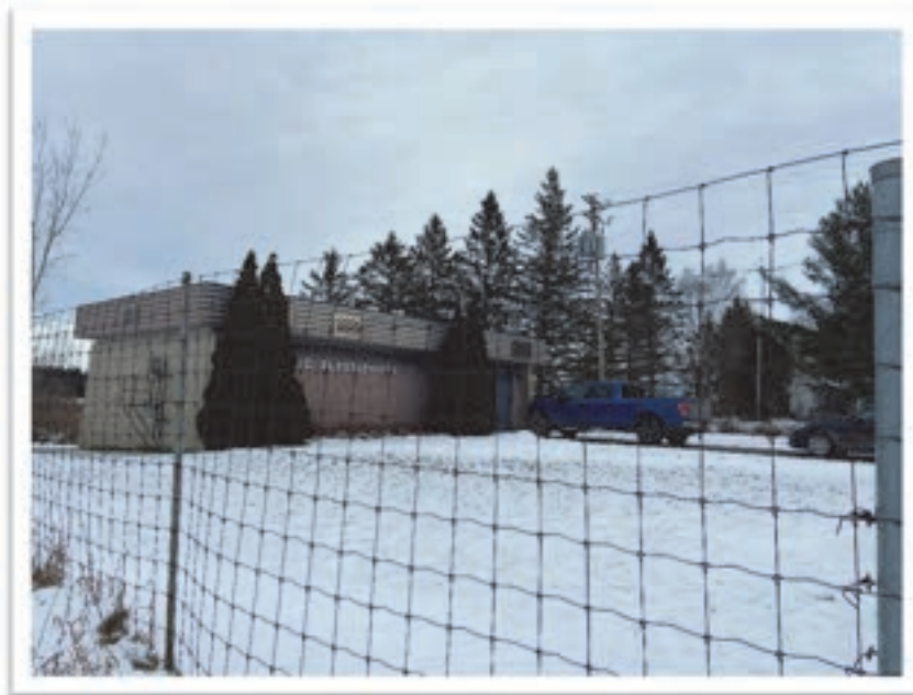
Photo 3 : Installation prise d'eau brute (secteur 659, rang St-Louis E) – 17 décembre 2020
