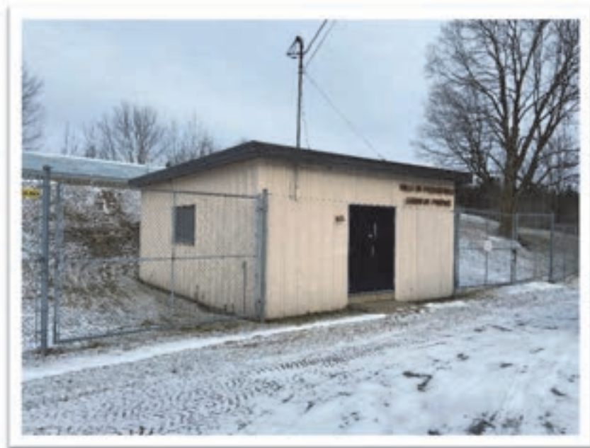
Photo 7 : Installation de la station de pompage #2 (secteur 2325, boulevard des Sucreries) – 17 décembre 2020
