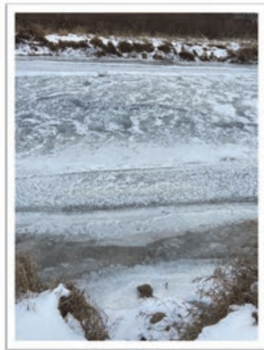
Photo 1 : Prise d'eau brute principale (secteur 659, rang St-Louis E) – 17 décembre 2020
