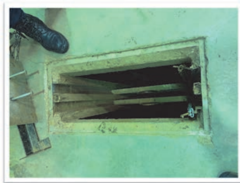
Photo 5 : Dégrillage pour bloquer les résidus provenant de la rivière Bécancour (secteur 659, rang St-Louis E) – 17 décembre 2020
