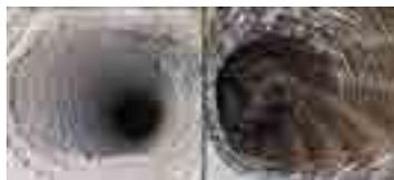
Dans ce conduit, il peut y avoir accumulation de charpie ce qui fait surchauffer la soufflerie de la sècheuse. Dans la très grande majorité des cas, c'est ce qui cause un incendie. Il est donc important de prendre le temps de déplacer la sècheuse et de nettoyer le conduit dans sa totalité soit, de la sècheuse jusqu'à la sortie extérieure, au moins une fois par année. Cela pourrait vous éviter bien des ennuis.
